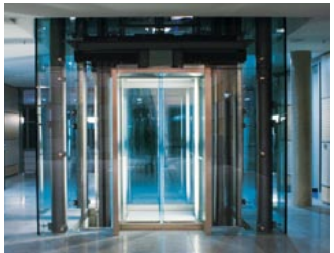
Aufzugsteuerung über Clex prime Schnittstelle
